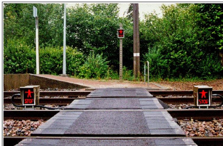
Sur ce type de TVP, le système d'annonce des trains se fait le plus souvent par pédale de détection des trains (et plus rarement par circuit de voie). Le délai d'annonce est de 15 secondes avant le passage de la circulation (et peut être allongé sans excéder 25 secondes).
