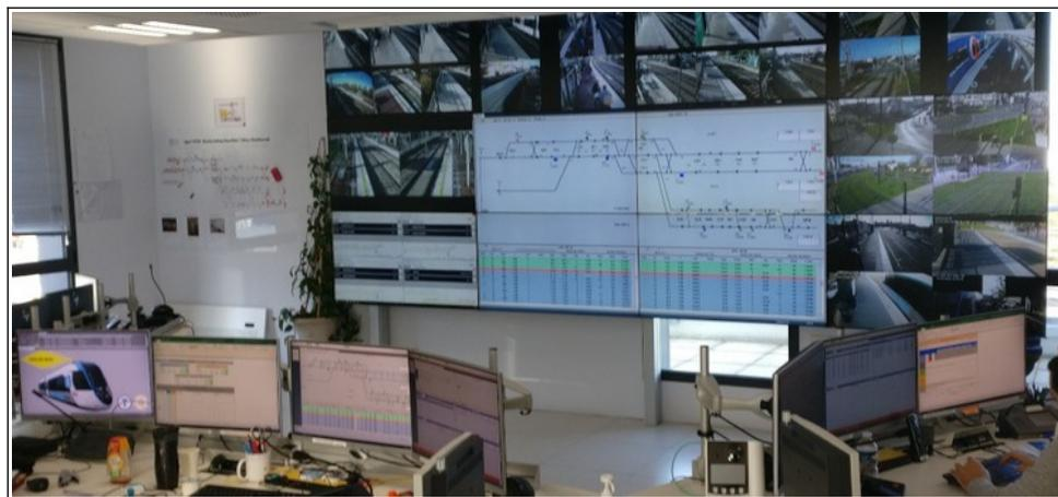
Figure 18 - Tableau synoptique et murs d'images de vidéoprotection au PCT4 (photo BEA-TT)
