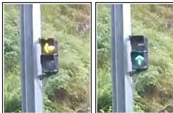
Figure 24 : États des feux de signalisation ferroviaire du Montenvers
