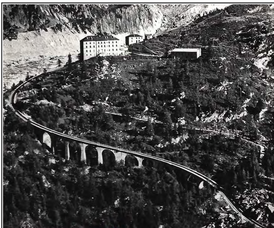
Figure 14 : Le viaduc en « S » en dessous du site du Montenvers
