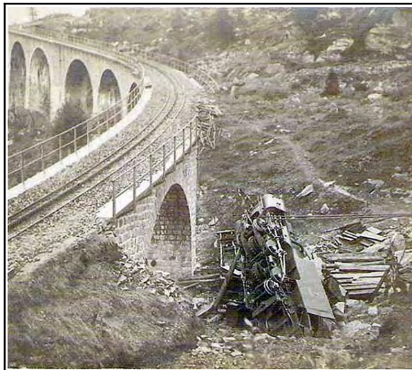
Figure 40 : Accident du 25 août 1927 au viaduc en « S » du Montenvers
