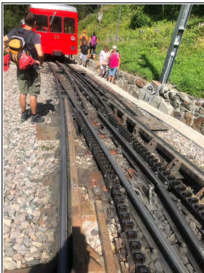
Figure 28 : Aiguillage aval peu après le déraillement : sa position en voie directe est bien visible
