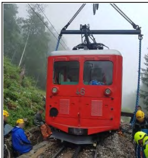
Figure 4 : Opérations de relevage sur le site
