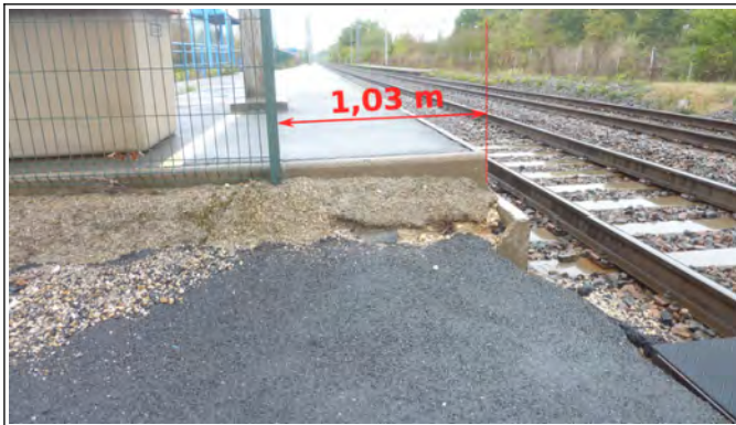
Vue 18a : la voie 2
