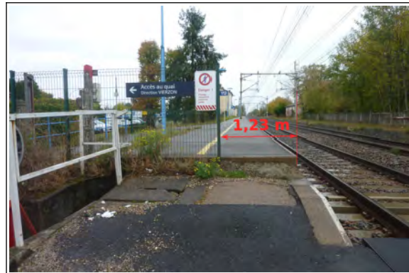
Vue 18b : la voie 1
