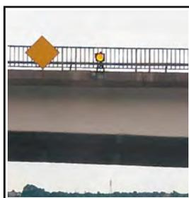
Figure 3 : Signal D1a indiquant la passe recommandée dans les deux sens et feu lumineux jaune associé
