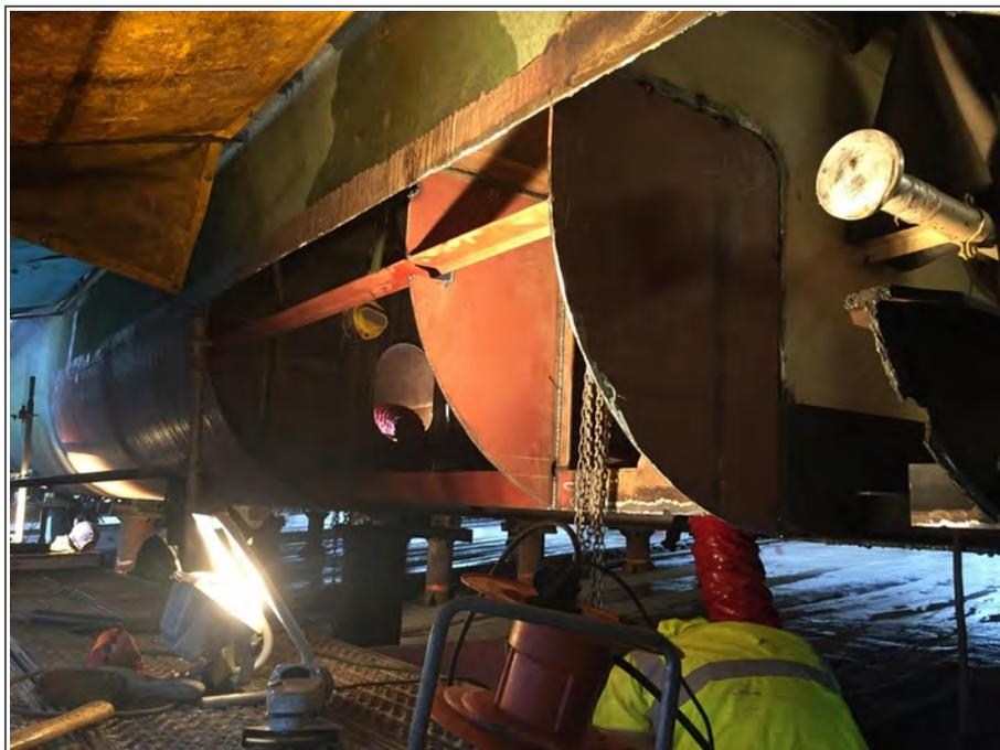
**Figure 20 : Structures internes réparées lors des travaux de novembre 2018**
