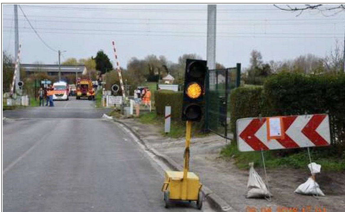
Figure 8 : Feux tricolores de chantier positionné dans le sens de circulation du VL accidenté
