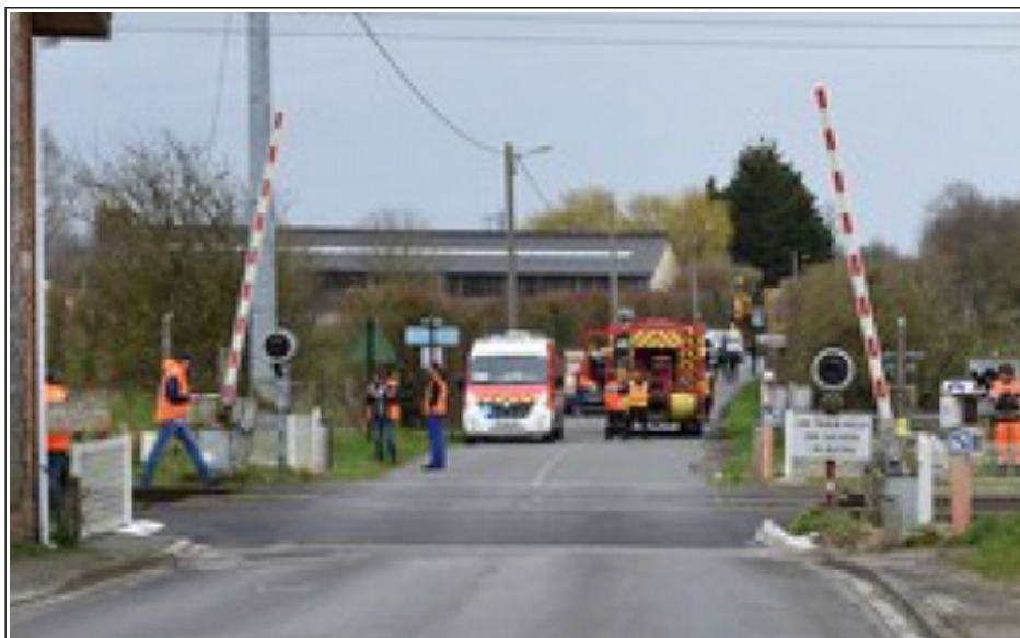
Figure 9 : État des lieux après l'accident, aucun dégât sur les équipements du PN82
