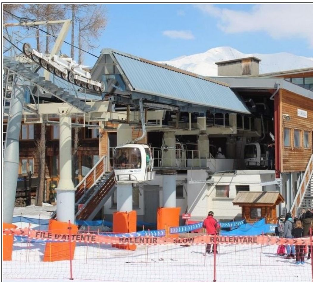
Figure 9 : gare basse avec le pylône n° 1 (en gris à l'extrémité gauche)
