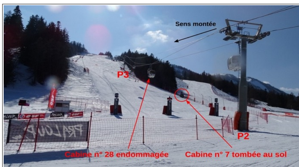
Figure 1 : localisation de l'évènement : la cabine n° 7 au sol et la cabine n° 28 abîmée en ligne
