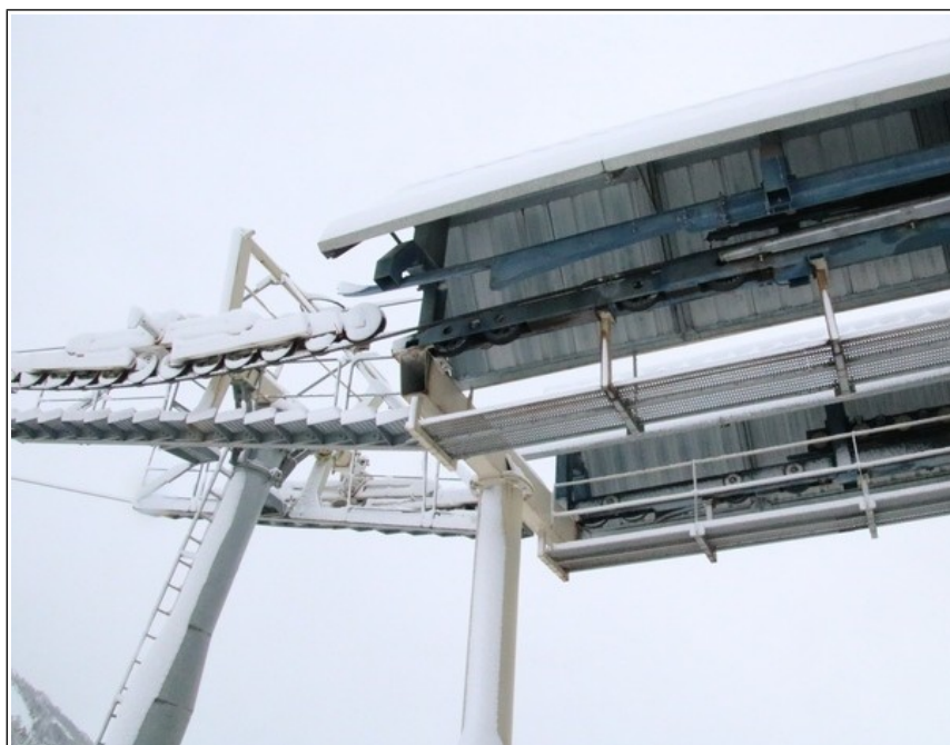
Figure 29 : pylône P1 et sortie de gare basse
