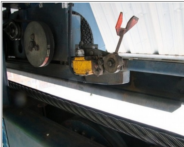
Figure 21 : la sécurité n° 1 sur la télécabine de Costebelle une fois déclenchée
