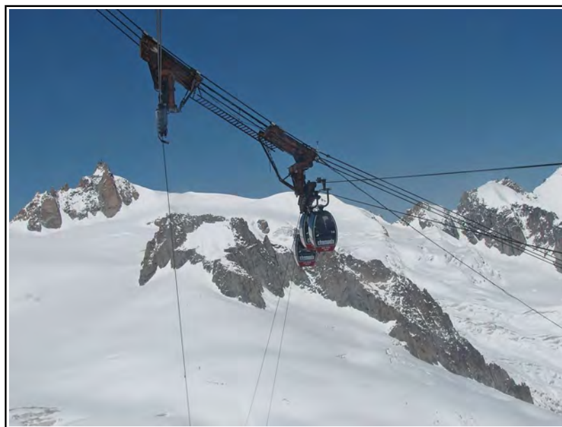
Figure 7 : vue du pylône suspendu du col des Flambeaux
