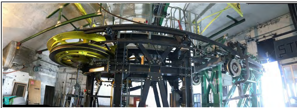
Figure 8 : vue panoramique (au grand angle) de la gare de la Pointe Helbronner
