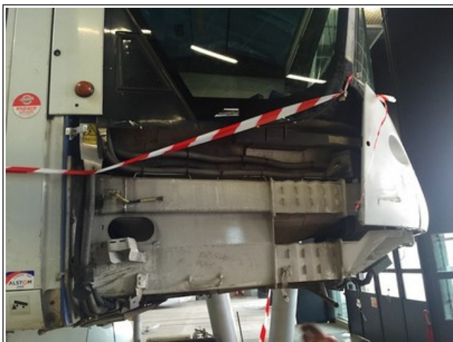
Fig. 11 : Zone de l'impact avec le véhicule sur l'avant droit de la cabine de la rame
