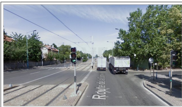
Fig. 23 : intersection de la route de la Courneuve avec la rue Voltaire avant l'accident
