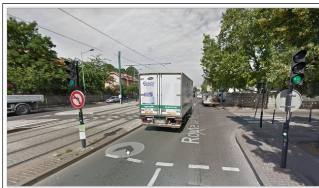
Fig. 24 : intersection de la route de la Courneuve avec la rue Voltaire modifiée après l'accident
