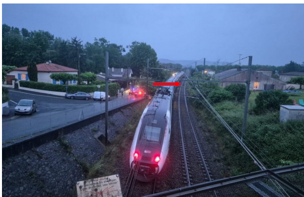
Figure 1 : TGV arrêté sur voie 1 et localisation de la brèche, le 19/05/2025 (photo Le républicain modifiée)
