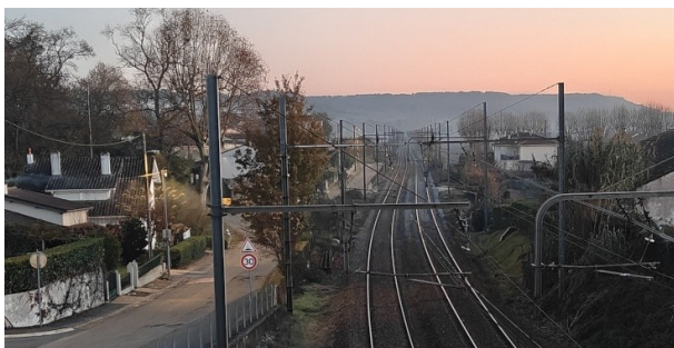
Figure 4 : Zone du déraillement (photo BEA-TT)
