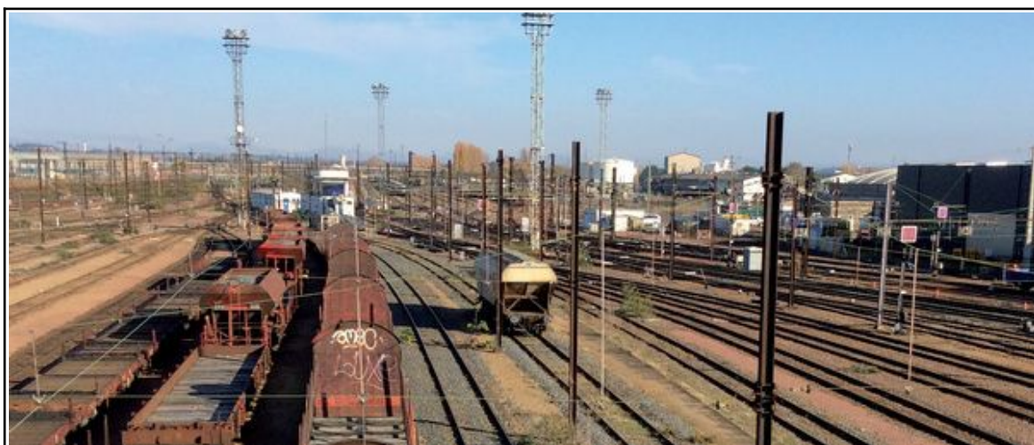
Figure 1 : faisceau de voies de service (Source SNCF Réseau)
