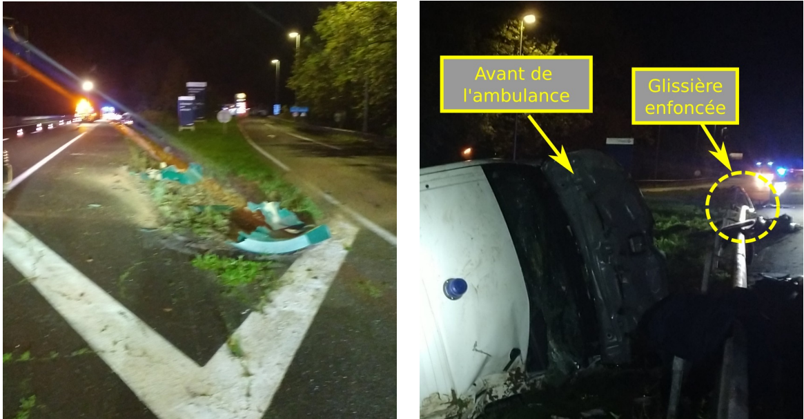
Figure 4 : à gauche, balise de divergent détruite (vue prise dans le sens de circulation de l'ambulance) à droite, portion de la glissière enfoncée (vue en sens inverse du sens de circulation de l'ambulance) Photographies Gendarmerie Nationale, légende BEA-TT
