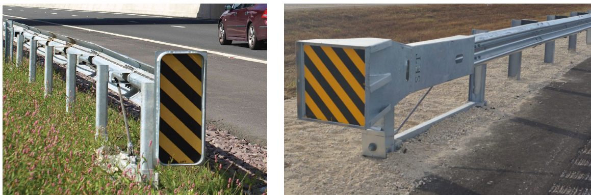
Figure 13 : Exemples d'extrémités dites performantes commercialisées hors Europe
