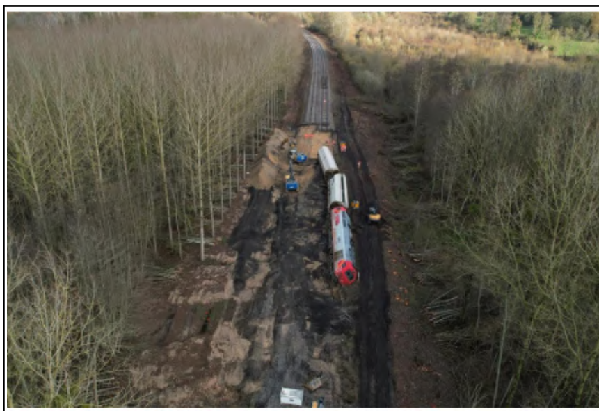
Figure 37 : Vue de la zone des travaux à réaliser Photo BEA-TT
