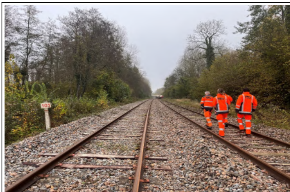
Figure 23 : vue générale du remblai Photo SNCF
