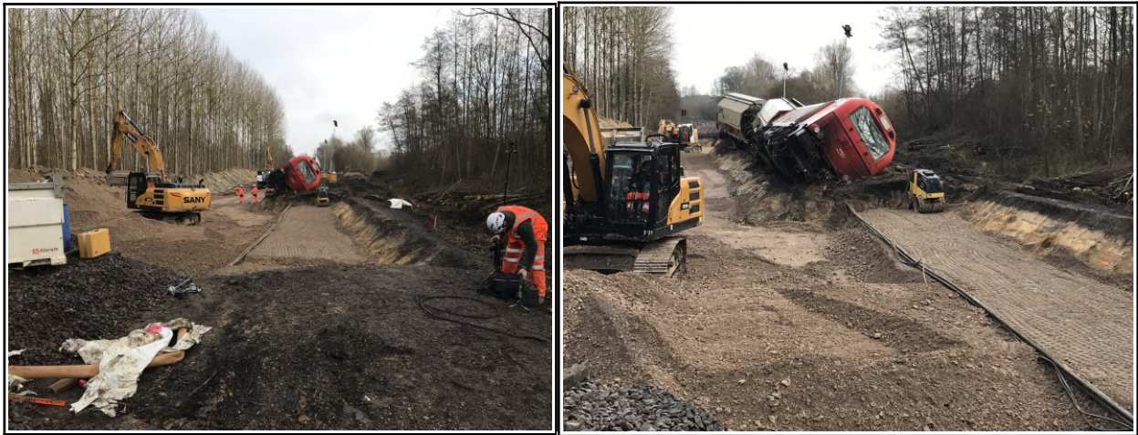
Figure 38 : Travaux de remise en état de la plateforme Source BEA-TT
