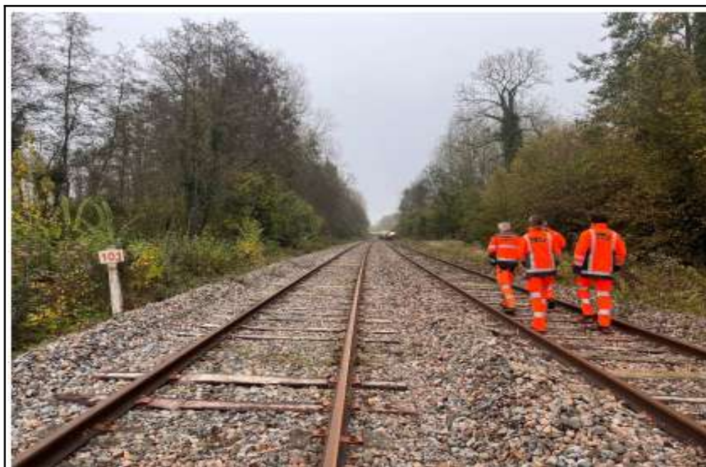
Figure 23 : vue générale du remblai Photo SNCF
