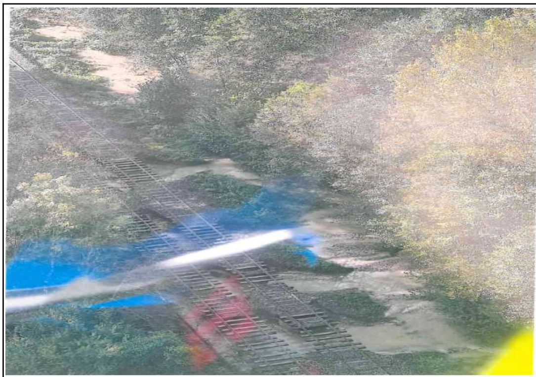
Figure 20 : Photo de la zone du déraillement prise en hélicoptère le 10 octobre 2024 à 16 h 18 lors de la tournée suite aux inondations de la tempête « Kirk » Photo préfecture de l'Aisne
