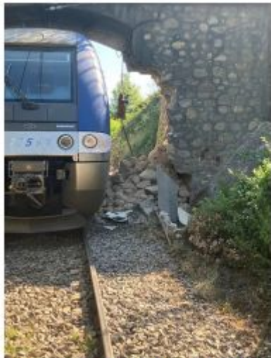
Dégâts à la pile de pont et au poteau caténaire
