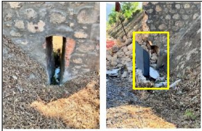
Figure 12 : Aqueducs traversant les deux lignes d'appuis – vue depuis Villefranche Source SNCF
