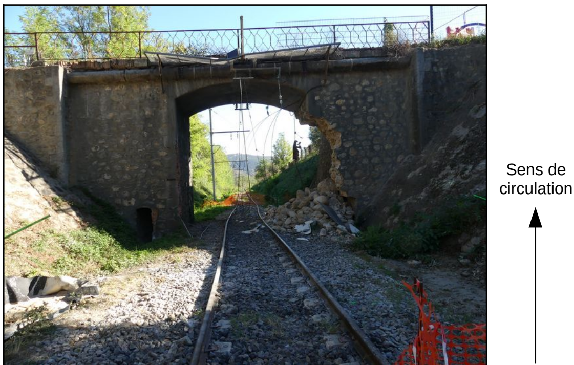
Figure 10 : Dégâts sur la voie et les caténaires Photo BEA-TT
