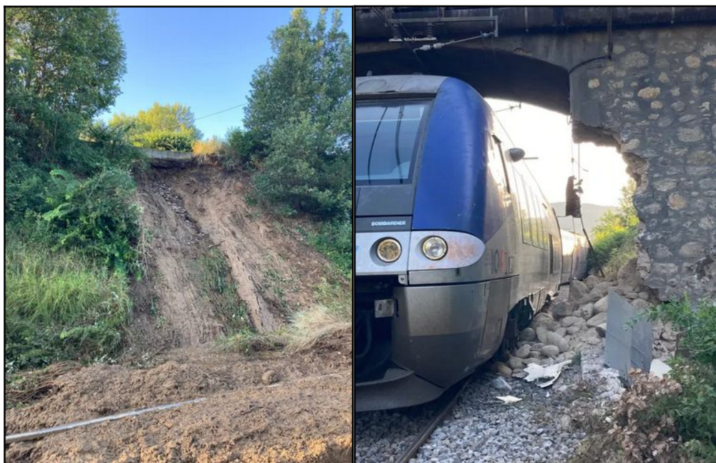
Figure 1 : Glissement de terrain et arrière de la rame TER immobilisé sous l'ouvrage d'art du PK 503,604 Source SNCF
