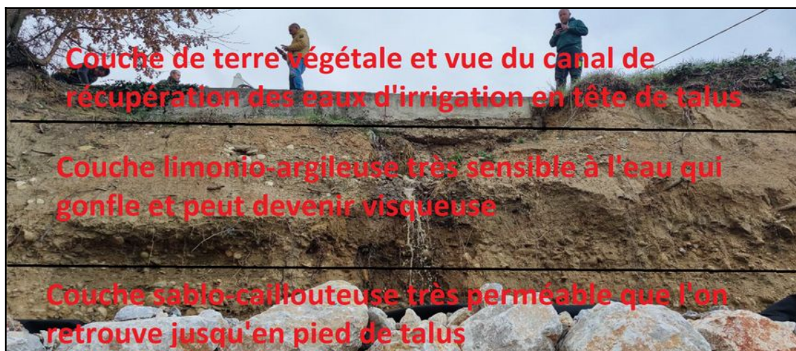
Figure 36 : Vue des couches géologiques dans le talus de la voie ferrée au niveau du glissement. Photo prise le 27/01/2025 Source rapport RTM
