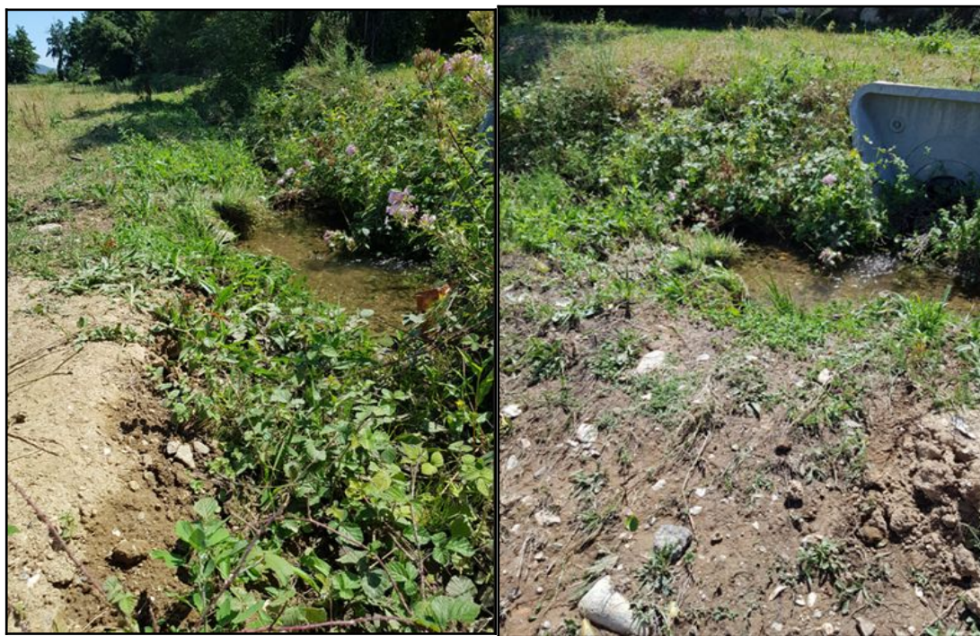
Figure 26 : Photo de gauche : érosion du bord aval du fossé de terre de redistribution (béal) Photo de droite : fossé répartiteur (béal). La végétation empêche le bon écoulement des eaux et donc la répartition de la lame d'eau sur l'ensemble du champ Source rapport TA
