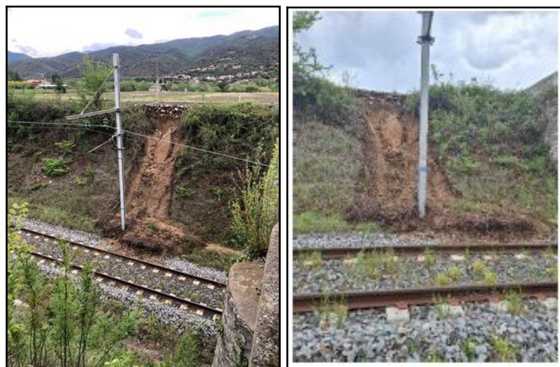
Figure 38 : Incident du 30/04/2024 sur talus de la voie ferrée au PK 503,920 Source SNCF Réseau
