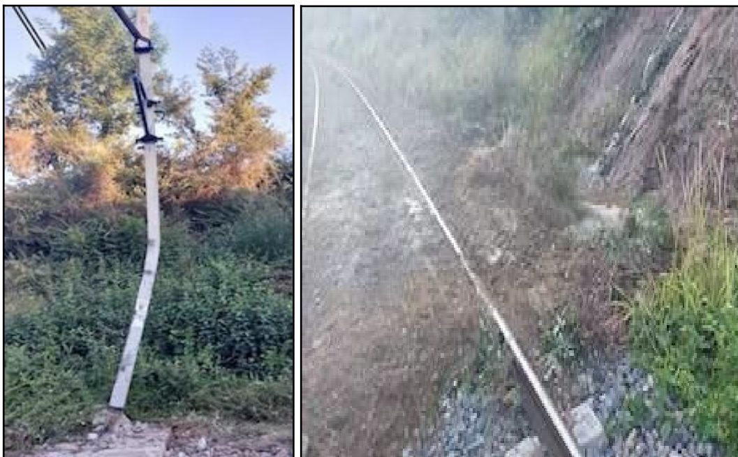
Figure 19 : Poteau caténaire abîmé (à gauche) et coulée de boue sur la voie (à droite) Source gendarmerie
