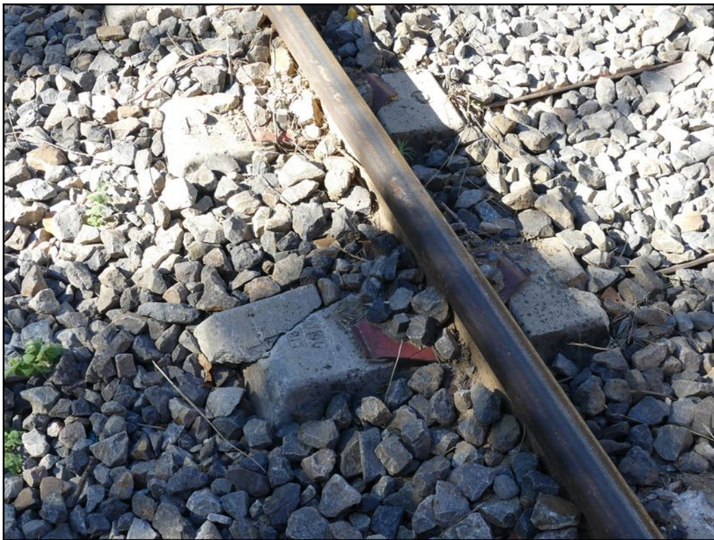
Figure 18 : Dégâts à la voie Source BEA-TT
