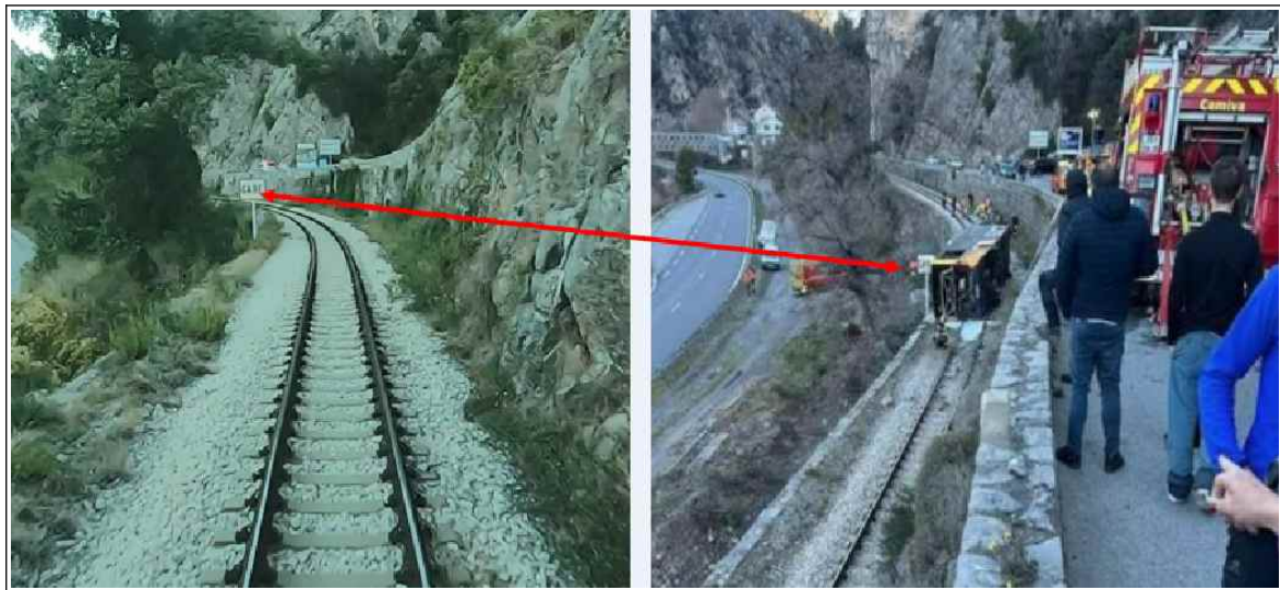
Figure 9: Bus immobilisé sur la voie ferrée après sa chute
