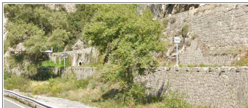
Figure 6 : Zone de la voie ferrée où s'est immobilisé le bus après sa chute (entre les 2 panneaux)
