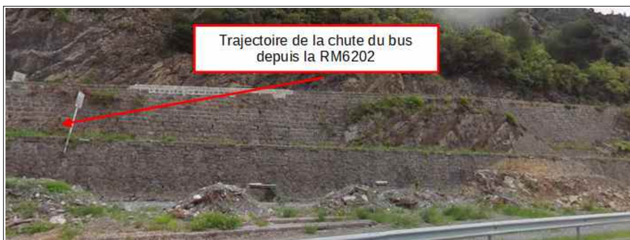
Figure 4 : Trajectoire de la chute du bus depuis la RM 6202 sur la voie ferrée du Train des Pignes (la partie plus claire du mur est celle détruite par le bus et depuis réparée)
