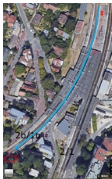
Gare de Bourg-la-Reine et localisation du train, de la chute du voyageur et du voyageur inanimé
