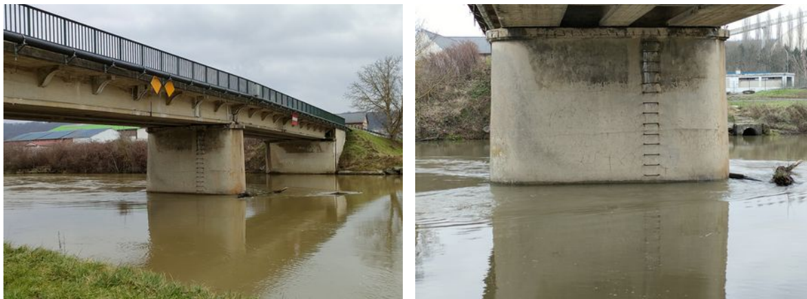
Figure 10 : Vue amont du pont et de la pile centrale le 23 janvier 2023 (source : BEA-TT)
