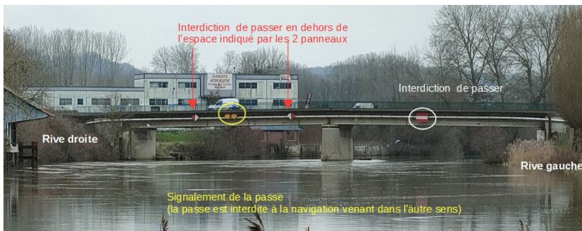
Figure 8 : Pont vu de l'aval (source : BEA-TT)
