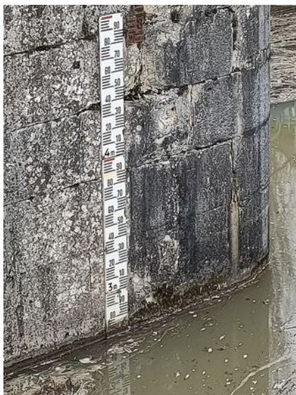
Figure 26 : Échelle limnimétrique à l'amont de l'écluse de Couloisy le 23 janvier 2023 (source : BEA-TT)
