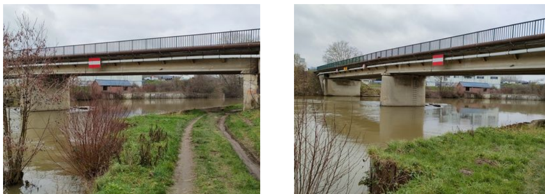
Figure 12 : Passage sous le pont bordant la culée rive gauche vue depuis l'aval (source : BEA-TT)
