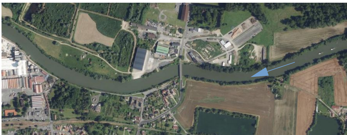
Figure 20 : Vue aérienne du linéaire de la rivière et de la localisation du pont (source : géoportail)
