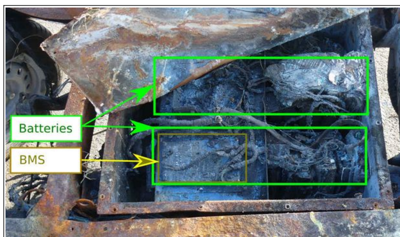
Figure 19 : vue des batteries et du BMS après l'accident photo et légende BEA-TT
