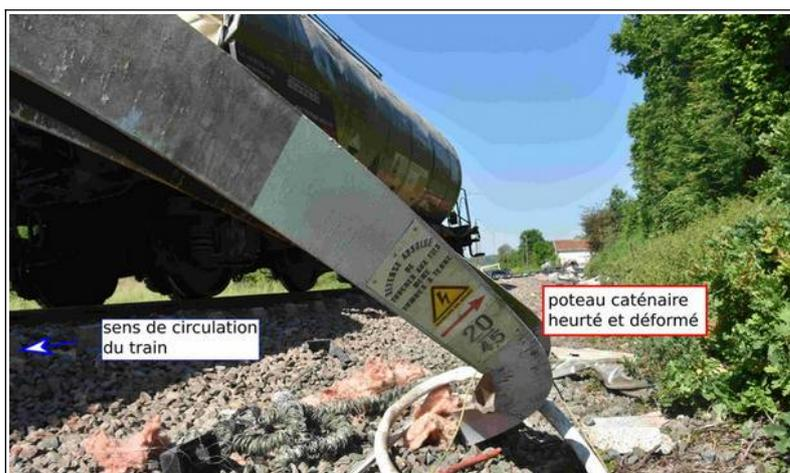
**Figure 21 : état des lieux : les dégâts aux infrastructures ferroviaires, exemple d'un poteau caténaire**
