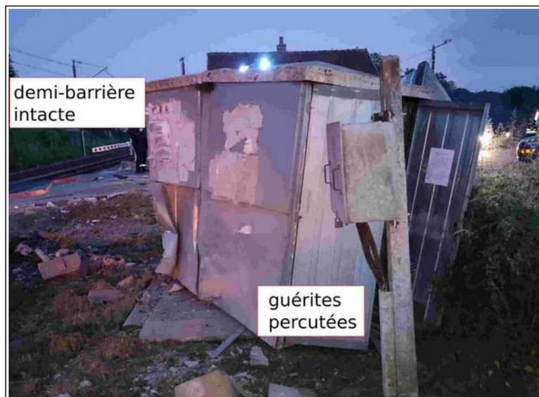
**Figure 19 : état des lieux : les dégâts sur les installations du passage à niveau**
