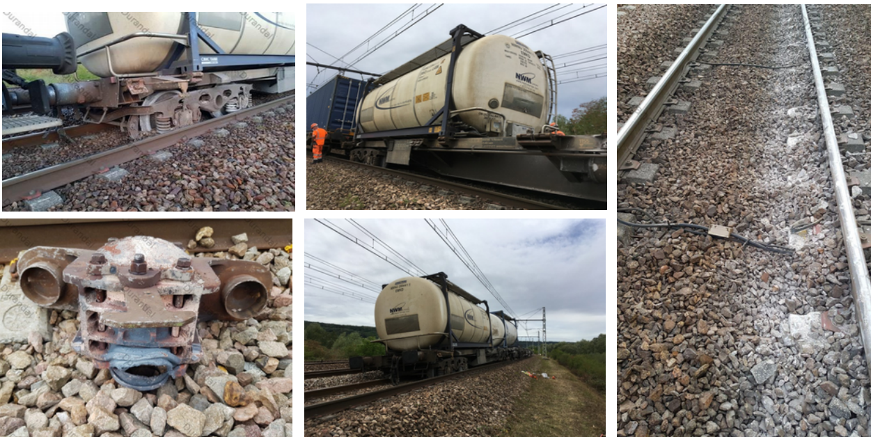
Wagon déraillé et voie en situation
