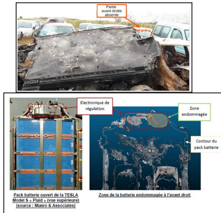
Figure 21 : Batteries de propulsion et localisation de l'électronique de régulation (photos expertise judiciaire et BEA-TT)
