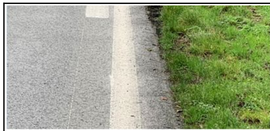
Figure 5 : Bord de chaussée (photo BEA-TT)
