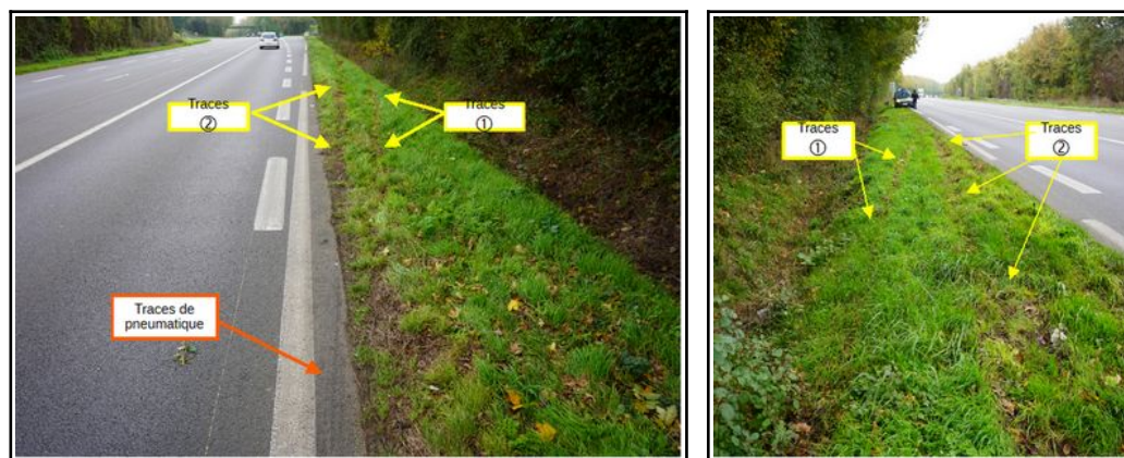
Figure 29 : Traces de pneumatique repérées sur la chaussée et dans le bas-côté (photos Gendarmerie nationale légendes BEA-TT)
