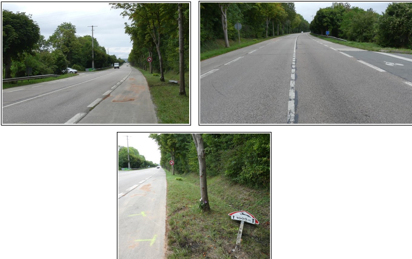
Figure 2 : Zone de la collision (2 photos du haut) et lieu d'immobilisation du véhicule léger contre l'arbre à côté du panneau de signalisation arraché (photo du bas) (source : Police)
