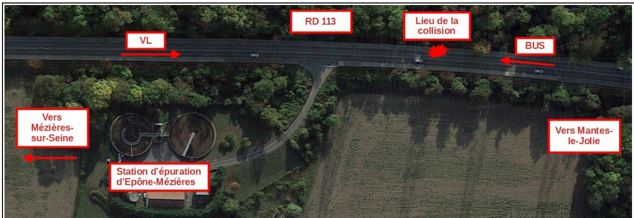
Figure 3 : Localisation de l'accident sur la RD113 avec sens de circulation des véhicules (Image Google Earth annotée par le BEA-TT)
