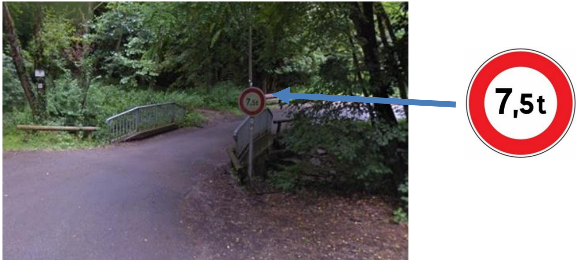
Figure 7 : Pont routier sur la rivière Sambach (Source Google Maps légendée BEA-TT)
