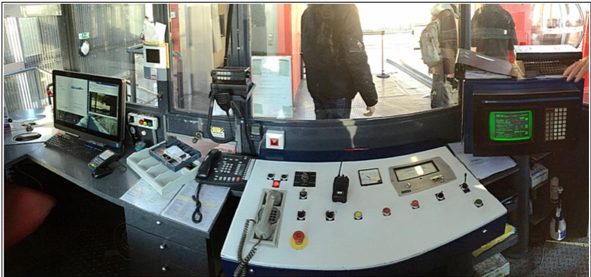
Fig. 8 : Le poste de commande du conducteur en gare inférieure
