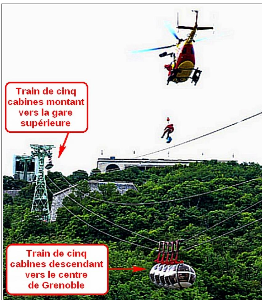
Fig. 1 : Vue du téléphérique de la Bastille après le déraillement de son câble tracteur
