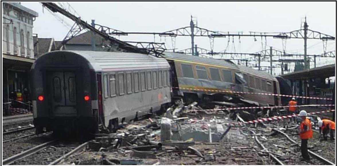
Figure 31 : Vue, vers Orléans, de la voiture n° 6 entre les voies 1 et 1bis et de la voiture n° 7 sur la voie 1bis
