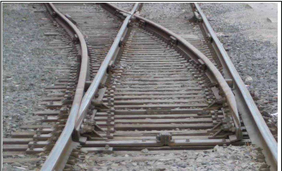
Figure 7 : Branchement simple avec déviation à gauche
