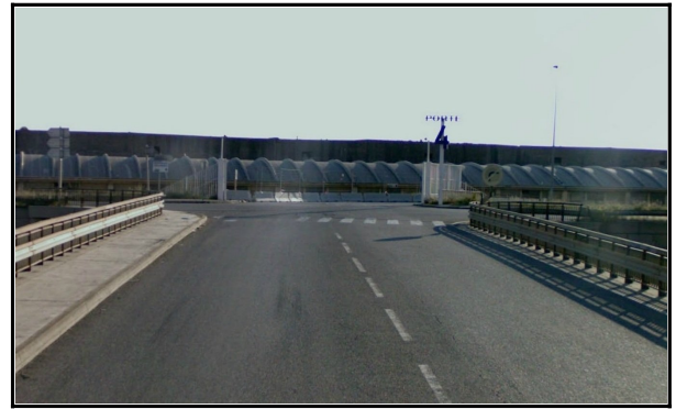
Figure 4 : Vue du carrefour depuis le pont enjambant l'A55 dans le sens de circulation du véhicule léger
