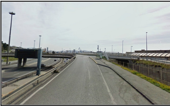
Figure 3 : Vue du carrefour depuis la bretelle de sortie du chemin du littoral dans le sens de circulation de l'autobus
