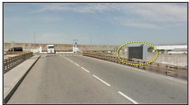
Figure 7 : Vue depuis le pont enjambant l'A55 du panneau à messages variables masquant en partie la visibilité à droite sur la bretelle de sortie du chemin du littoral
