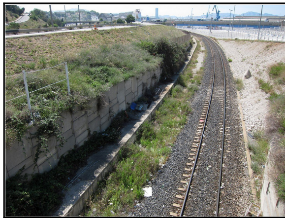
Figure 8 : Vue depuis l'accès n° 4 au port, de la voie ferrée longeant la bretelle d'accès à la RD 5
