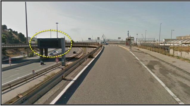
Figure 6 : Vue depuis la bretelle de sortie du chemin du littoral du panneau à messages variables masquant en partie la visibilité sur le pont surplombant l'A55
