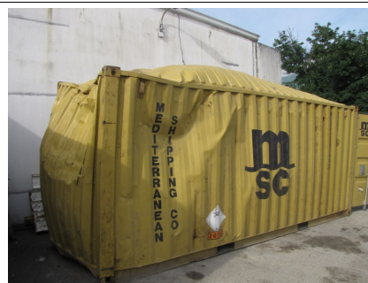
Photo n°3 : conteneur contenant du Toluène
