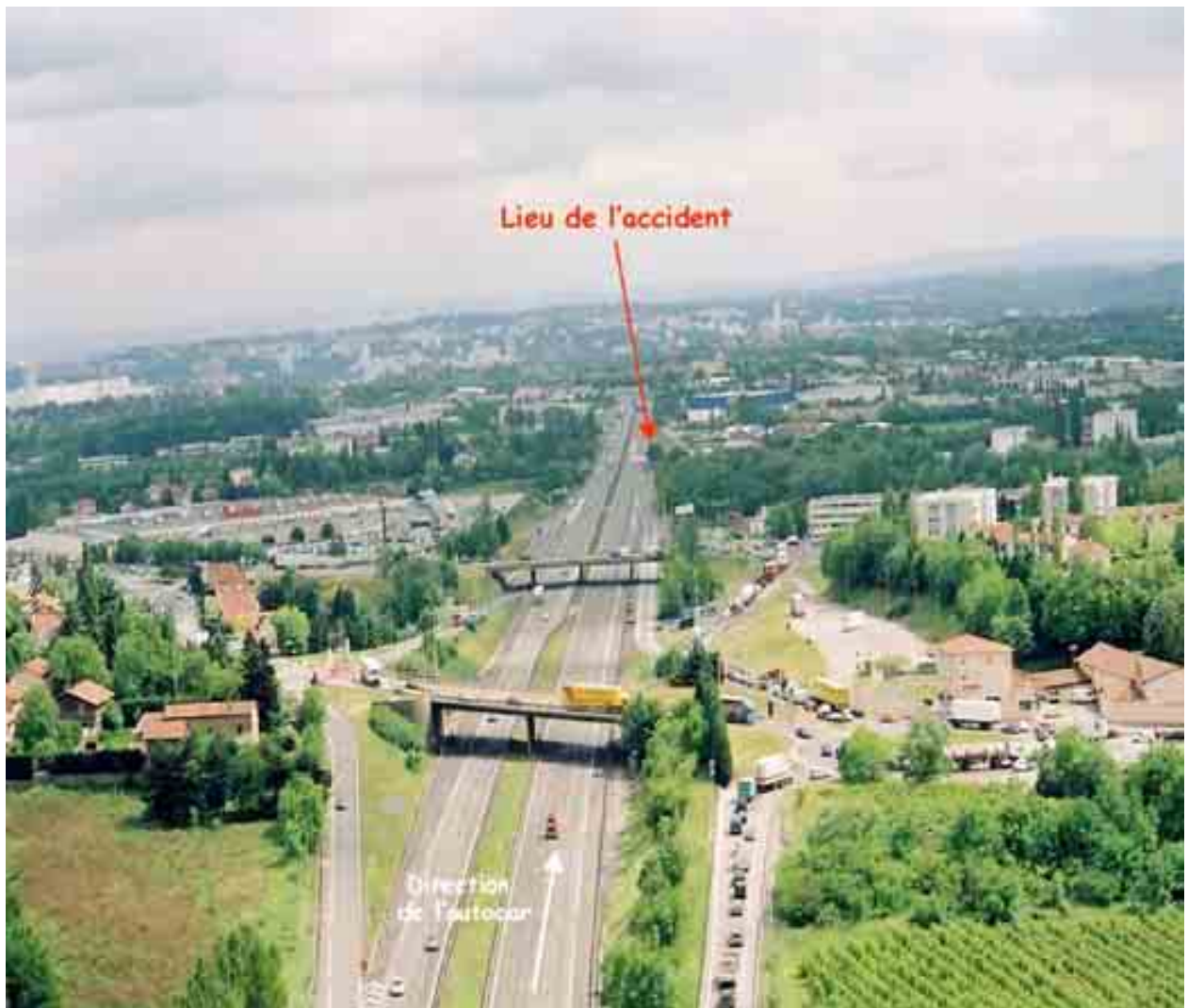
Figure 2 : Vue de l'autoroute A6 en amont de l'accident.
