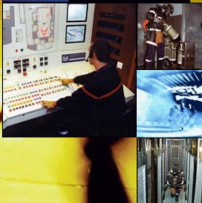
Un **automate de gestion** assure en permanence, une lecture des différents capteurs de température, de monoxyde de carbone, de propane et d'oxygène
