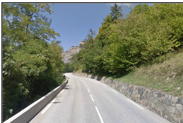
Figure 3 : Vue de la RD 211 dans le sens L'Alpe-d'Huez / Le Bourg-d'Oisans sur une section aval entre les virages n° 20 et n° 21
