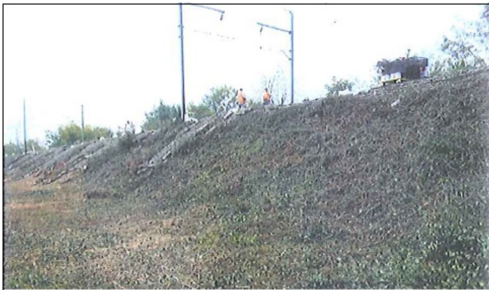
Figure 18 : Vue du remblai côté voie 1 à la hauteur du point de déraillement
