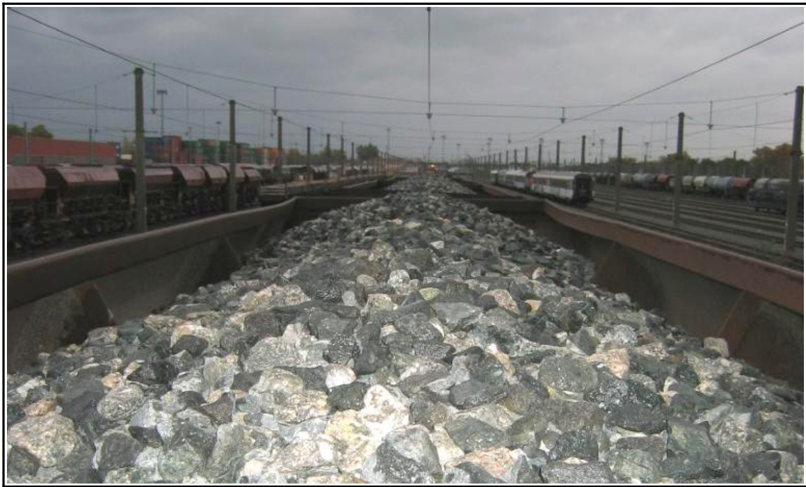
Figure 11 : Vue du centrage du ballast sur les wagons trémies du train
