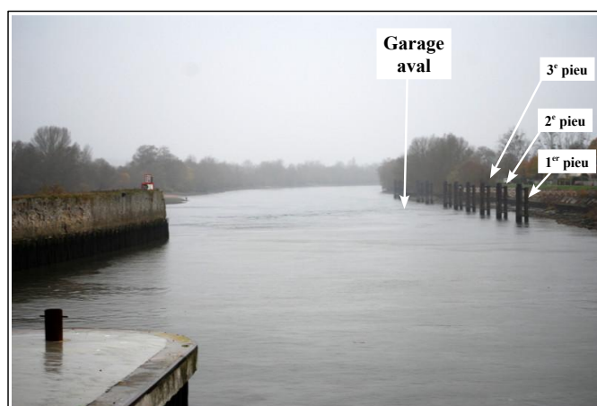
Figure 4 : Vue du garage aval depuis la grande écluse d'Amfreville-sous-les-Monts
