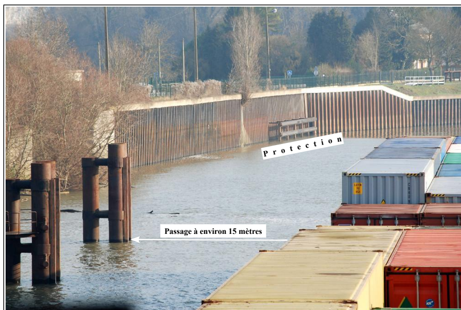
Figure 17 : Visualisation d'une manœuvre d'entrée dans la grande écluse d'Amfreville-sous-les-Monts. Le convoi passe à une quinzaine de mètres des ducs-d'Albe du garage aval en suivant une route voisine de la « route 2 ».
