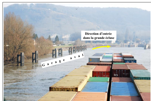
Passage le long du garage aval pour se présenter à l'entrée de la grande écluse
