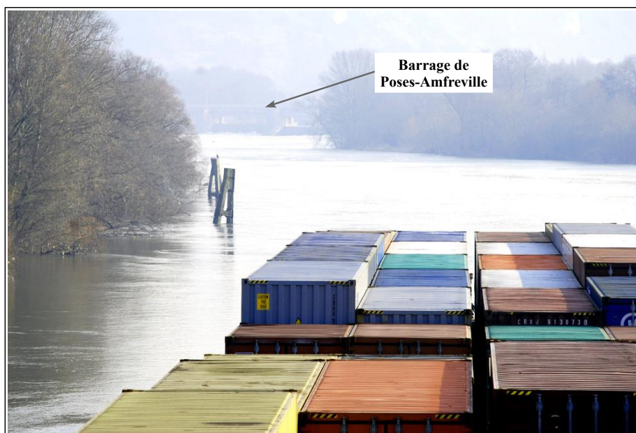
Figure 6 : Navigation gauche-gauche à l'approche aval des écluses d'Amfreville-sous-les-Monts
