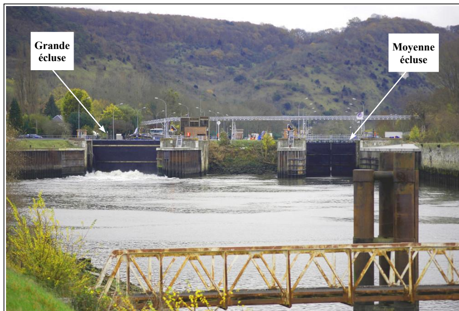
Figure 3 : Vue des entrées aval des écluses d'Amfreville-sous-les-Monts depuis le garage aval
