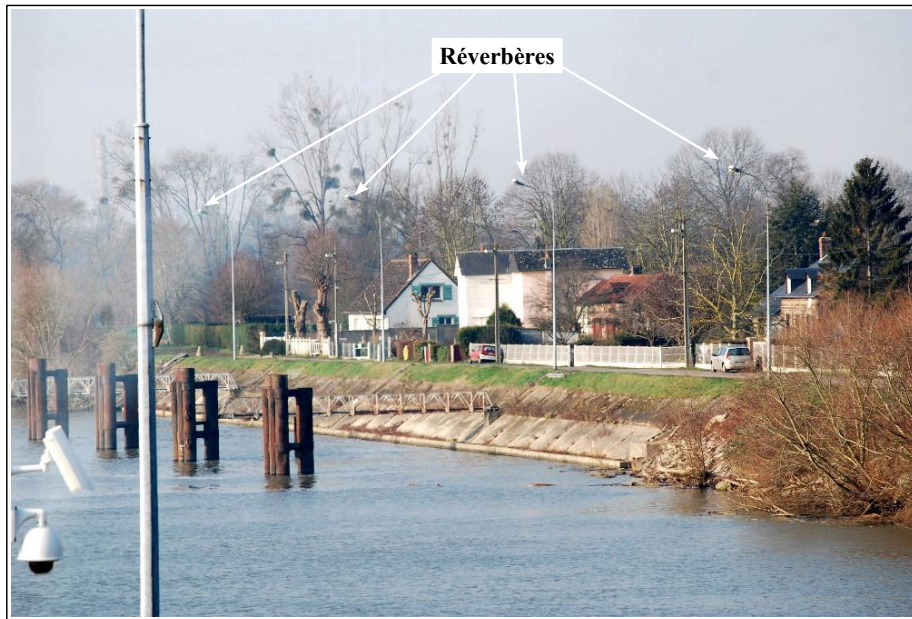
Figure 18 : Vue des réverbères éclairant la rive, situés à proximité du garage aval
