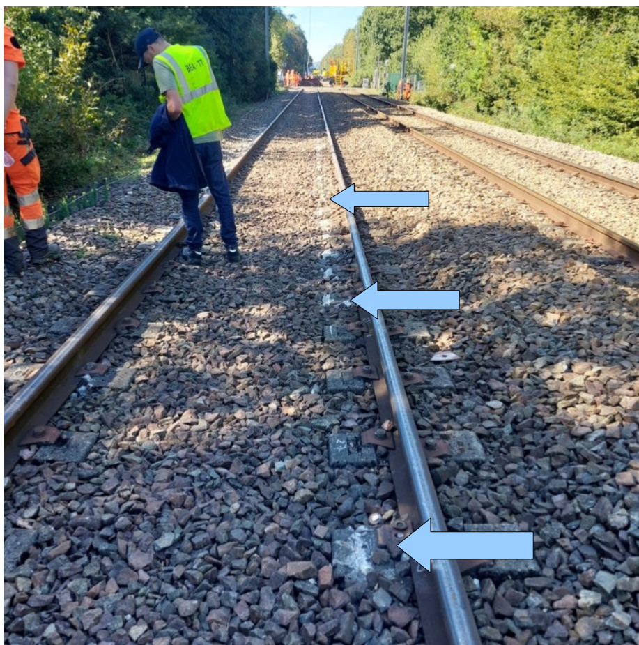
Photo des traces de déraillement du train à partir du point d'impact Source BEA-TT
