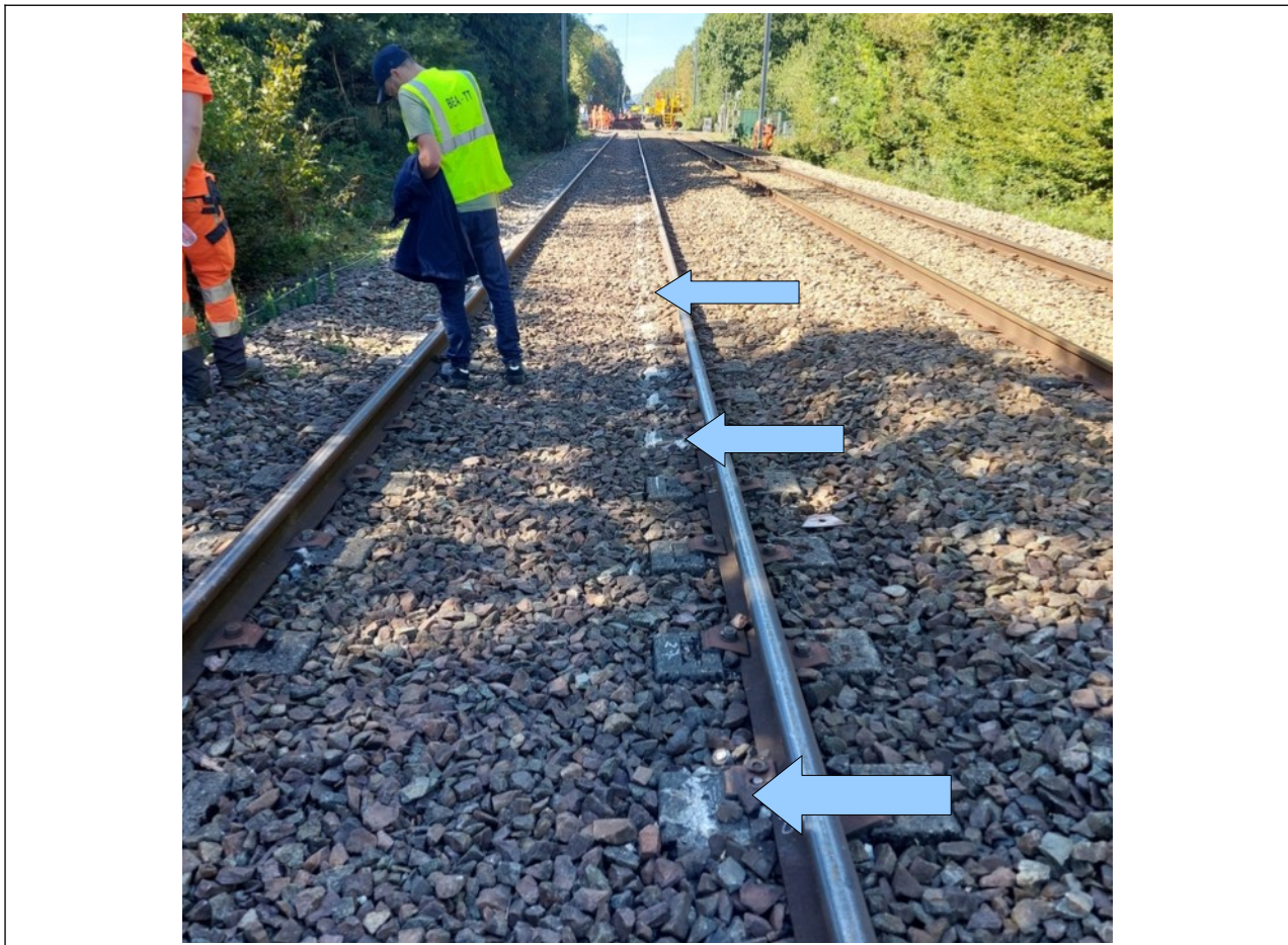
Photo des traces de déraillement du train à partir du point d'impact Source BEA-TT
