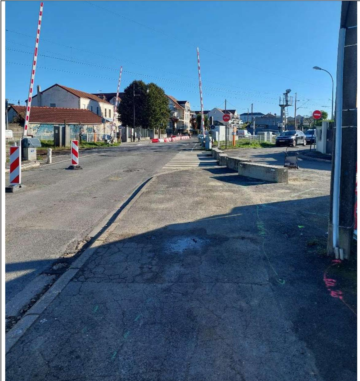
Côté nord-est des voies ferrées, des dispositifs en béton empêchent l'accès au PN depuis les rues secondaires.
