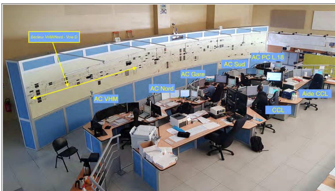
Vue 4 : salle d'exploitation et les postes de travail en temps normal
