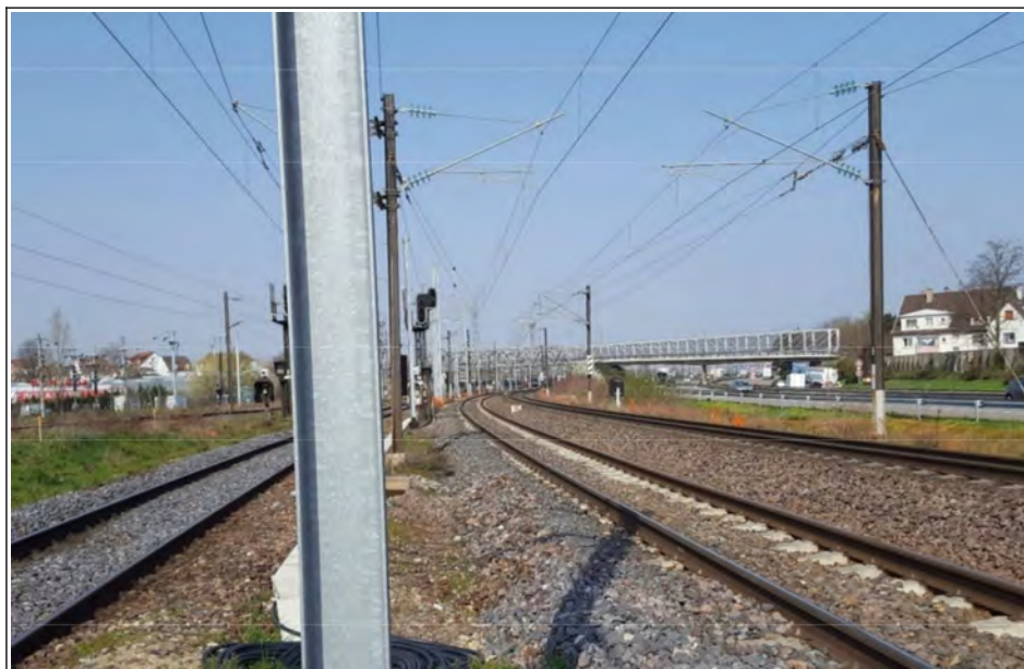
Vue 14 : environnement de l'extrémité nord du parcours
