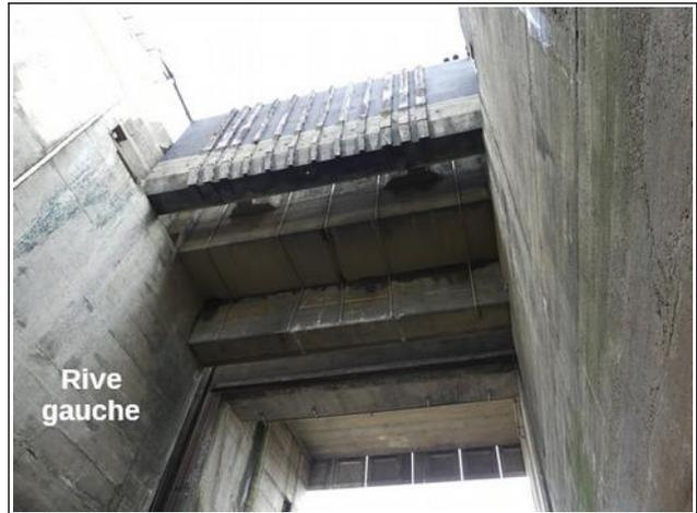
La tête de l'écluse est constituée de plusieurs poutres en béton : une première sur laquelle est adossée le pare-choc, puis deux autres qui descendent plus bas et entre lesquelles coulisse la partie supérieure de la porte.
