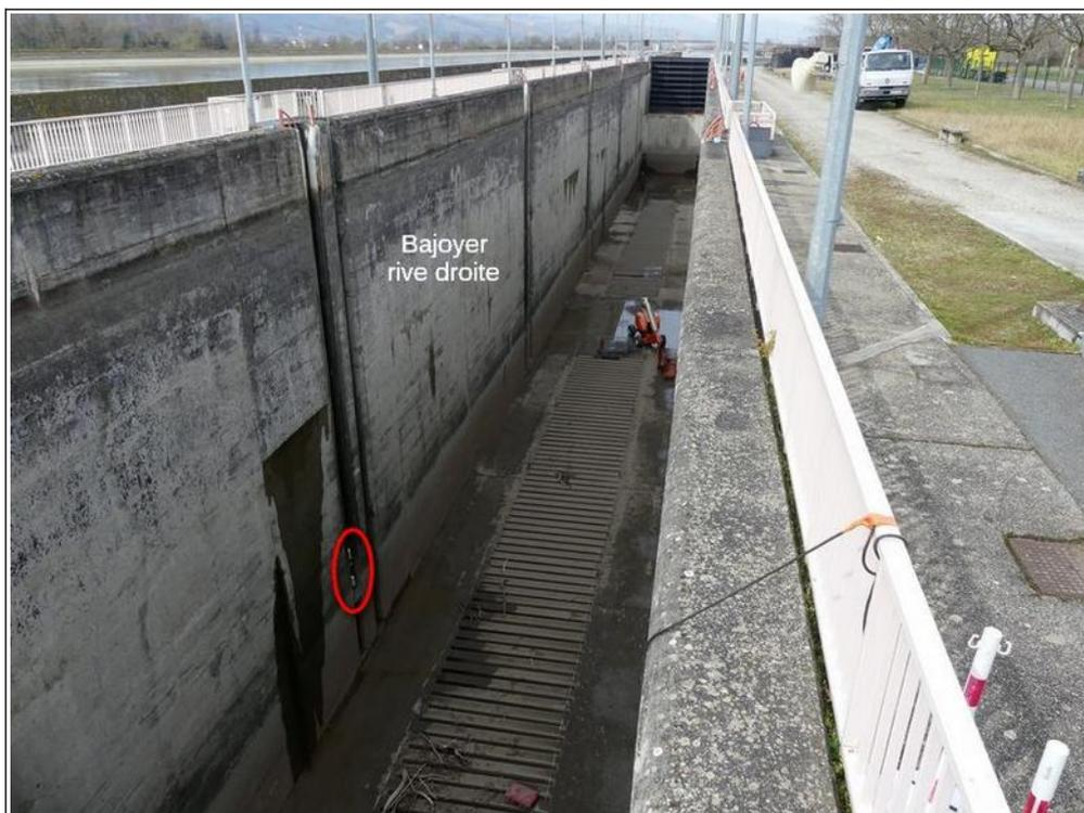
Le sas comporte, dans chacune de ses parois latérales, six rainures verticales pour bollards flottants, servant à l'amarrage des bateaux. Ces bollards sont fixés sur un cylindre métallique qui coulisse à l'intérieur des rainures en suivant le niveau de l'eau dans le sas.
