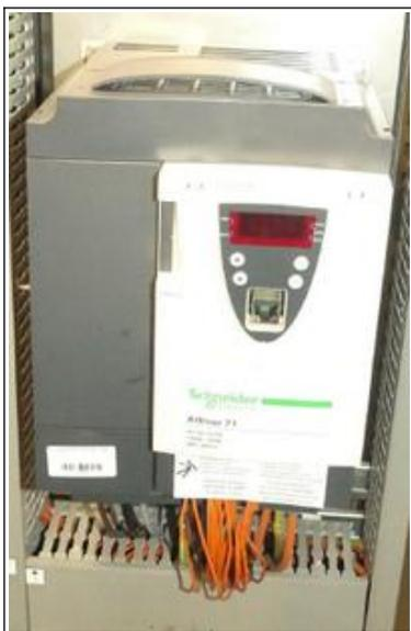
L'écluse de Sablons est équipée de deux variateurs, modèle Altivar 71 de la marque Schneider electric, installés dans l'usine attenante. Un seul variateur est actif et est utilisé pour piloter les deux portes de l'écluse, une rotation entre les deux est effectuée en cours d'année ou chaque année.
