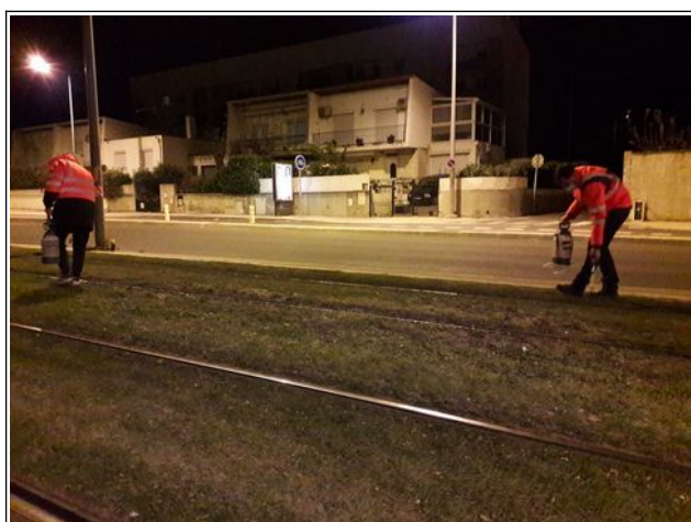
Figure 56 - Pulvérisation sur le rail du produit de graissage de boudin (photo BEA-TT)
