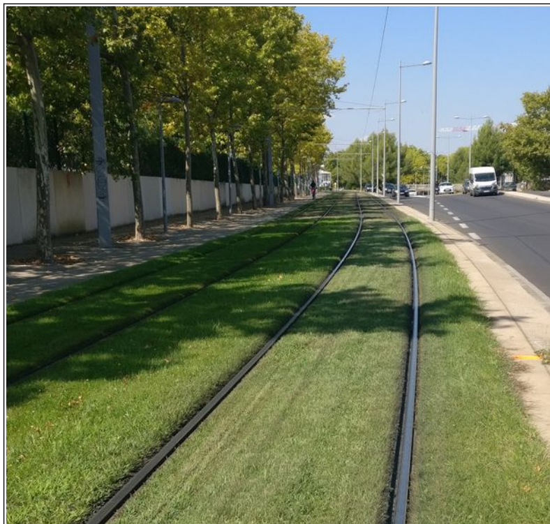
Figure 8 - Plateforme tramway 50 mètres en amont de la zone de la collision (photo BEA-TT)
