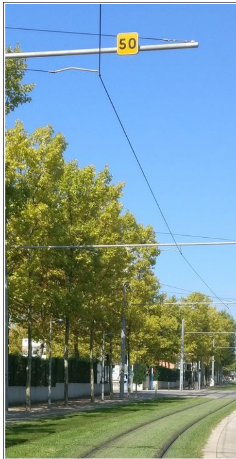
Figure 5 - Indication de limitation de vitesse à 50 km/h, sur la ligne 1, route de Ganges (photo BEA-TT)
