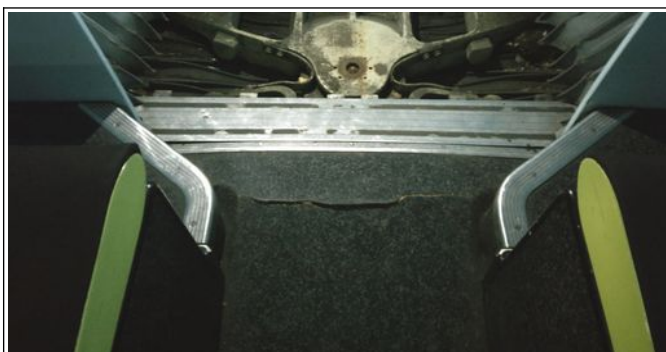
Figure 21 - Déformation du châssis au niveau de la nacelle du tramway n° 2028 (photo BEA-TT)
