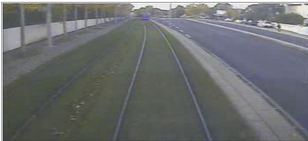
Figure 36 - État de la voie devant le tramway n° 2028 – milieu du freinage (vidéo frontale du tramway n° 2028)
