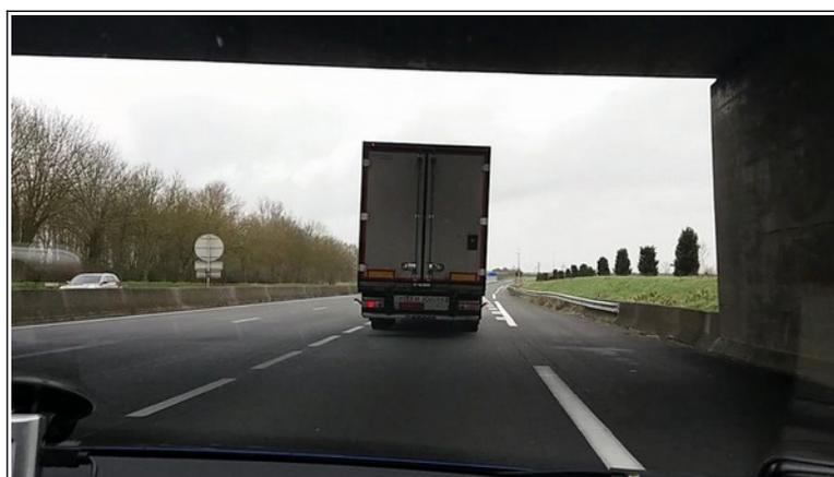
Le marquage de la ligne de rive est identique entre celui en bord droit de la voie de droite en section courante et en bord droit de la bretelle de sortie, soit une ligne discontinue de type T4 (traits de longueur 39 m).
