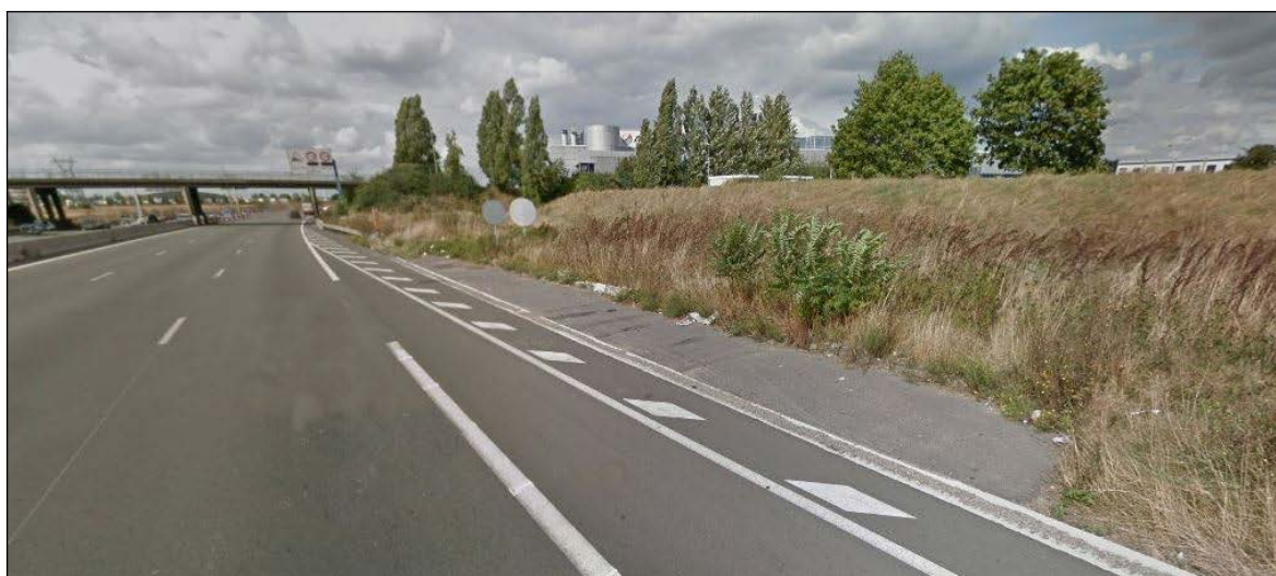
Figure 3 : Vue de la surlargeur où s'est garé l'autocar
