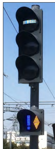
Figure 17 : Signal R17 et SAC sur la ligne T7 (photo BEA-TT)
