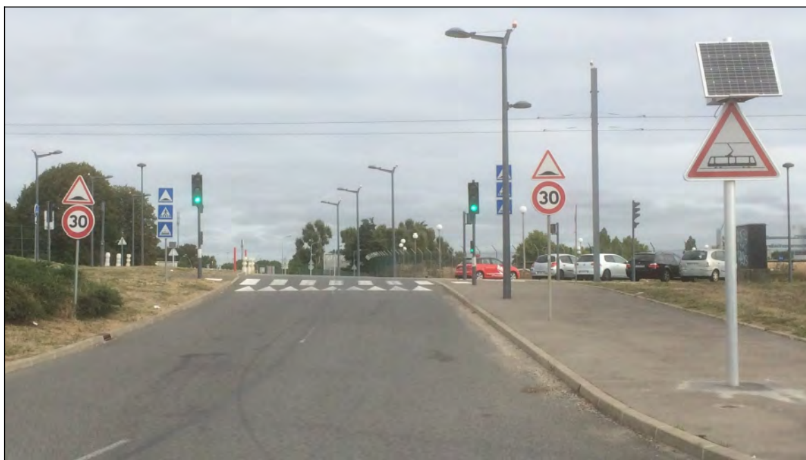
Figure 31 : Vue vers le carrefour n° 38 dans le sens de circulation sud-nord, après déplacement de la signalisation de position (photo BEA-TT)
