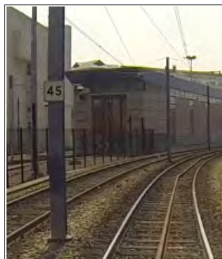
Figure 16 : indicateur de limitation de vitesse sur la ligne T2 : TIV 45 à proximité de la station Jacques-Henri Lartigue
