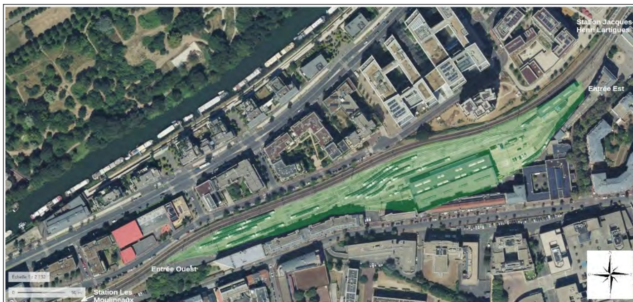
Figure 19 : vue satellitaire du SMR des Moulineaux (zone surlignée en vert), au sud des deux voies de circulation en exploitation
