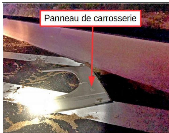
Figure 13 : Emplacement du panneau de carrosserie au niveau des zébras
