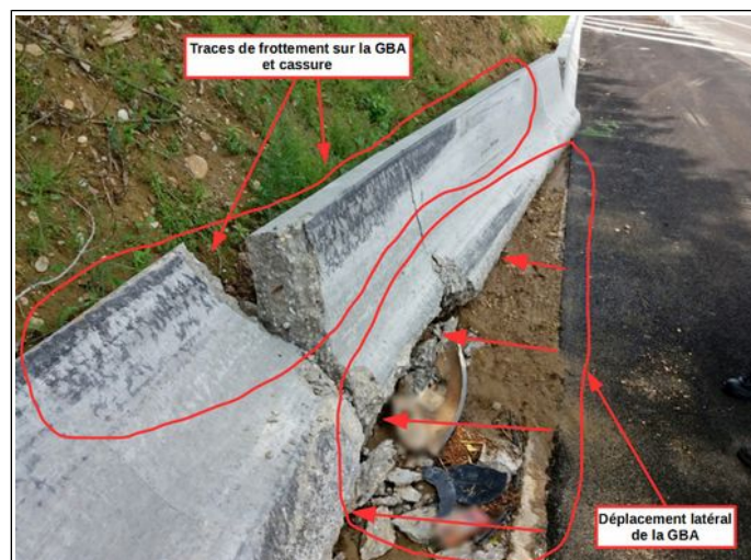
Figure 15 : Zone du premier choc de l'autocar contre la GBA
