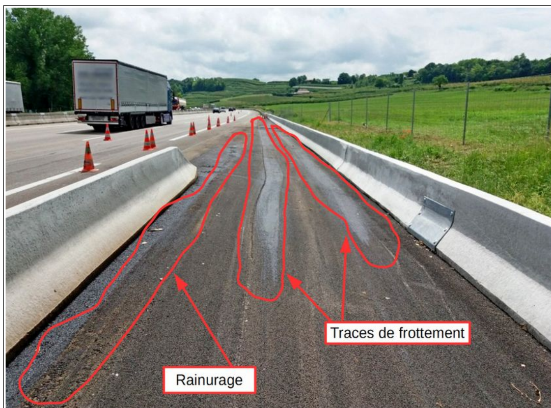
Figure 20 : Traces de l'accident en aval du pont proches de la position finale de l'autocar
