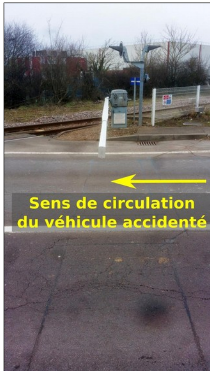
Figure 11 : Vues de la demi-barrière fermant le sens de circulation de Troyes vers Auxerre : à gauche en configuration normale, et à droite le soir de l'accident
