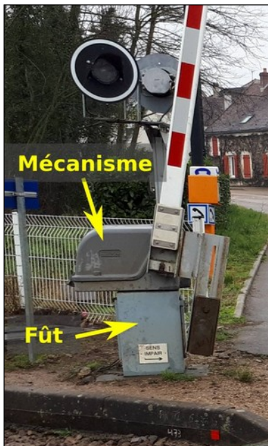
Figure 12 : Vue du support de la demi-barrière du PN fermant le sens de circulation Troyes vers Auxerre
