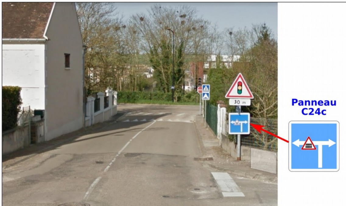
Figure 6 : Vue depuis la rue Neuve de la signalisation routière avancée annonçant le passage à niveau
