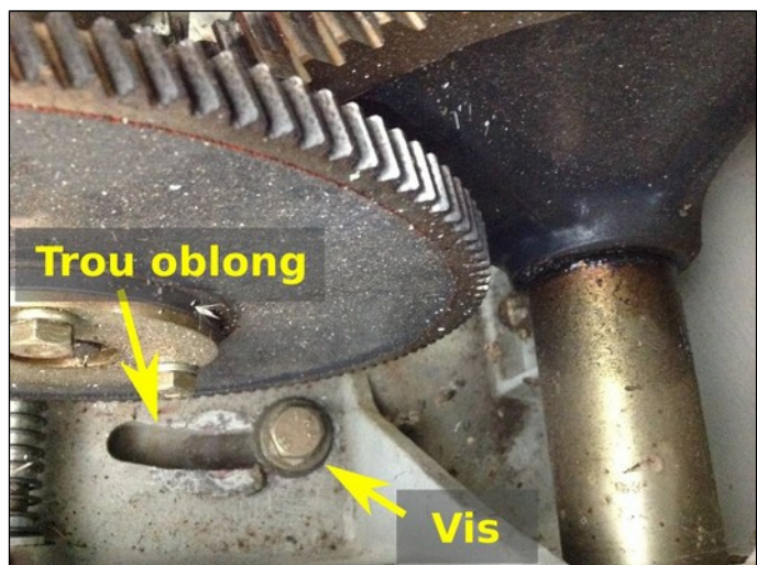
Figure 13 : Vue de l'intérieur d'un mécanisme de demi-barrière similaire à celui équipant le PN n° 19
