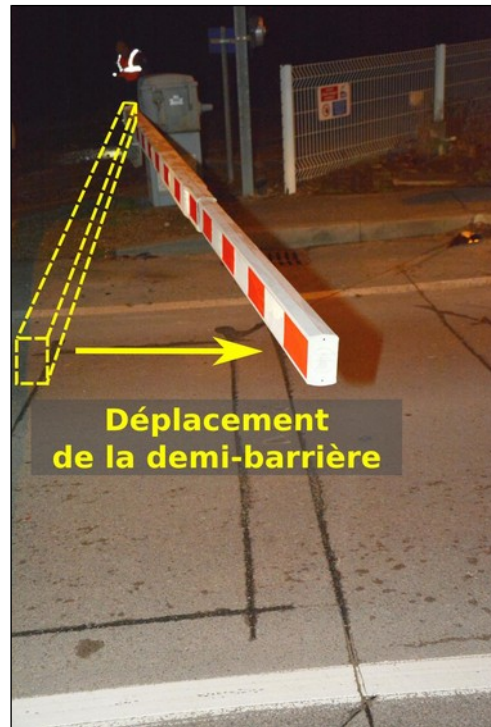
Figure 11 : Vues de la demi-barrière fermant le sens de circulation de Troyes vers Auxerre : à gauche en configuration normale, et à droite le soir de l'accident
