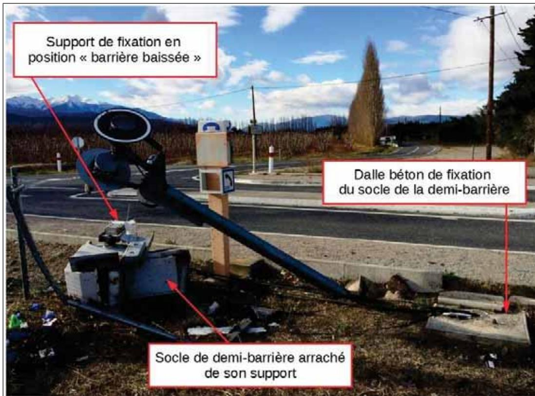
*Figure 41 : Autre vue des équipements du passage à niveau*
