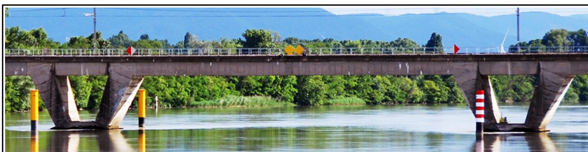
Figure 15 : Passe des bateaux avalants sous le pont SNCF de La Voulte-sur-Rhône
