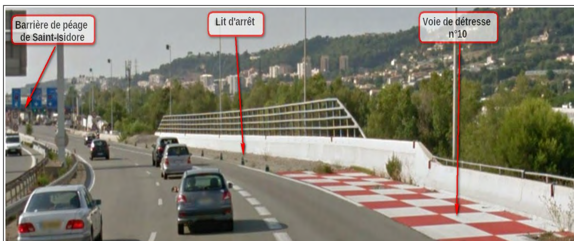
Figure 19 : Le dernier lit d'arrêt avant la barrière de péage de Saint-Isidore
